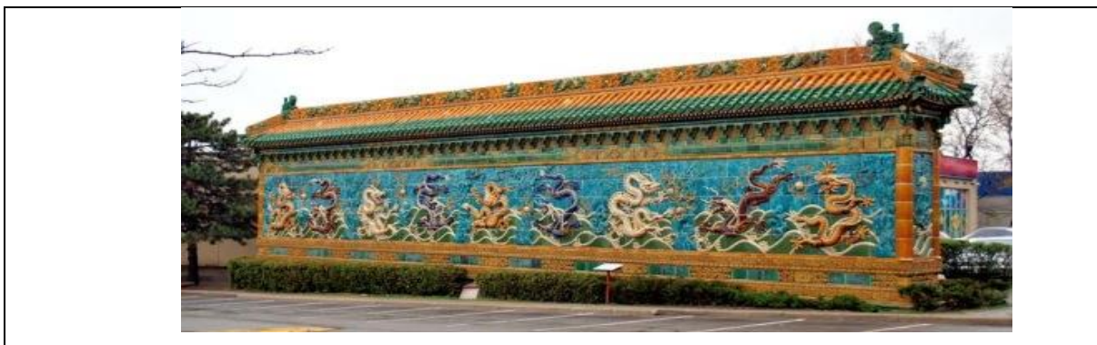
Figura 15. Parede dos Nove Dragões.
